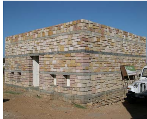
Fig 11. – Construcción de mampostería sismorresistente en La India
