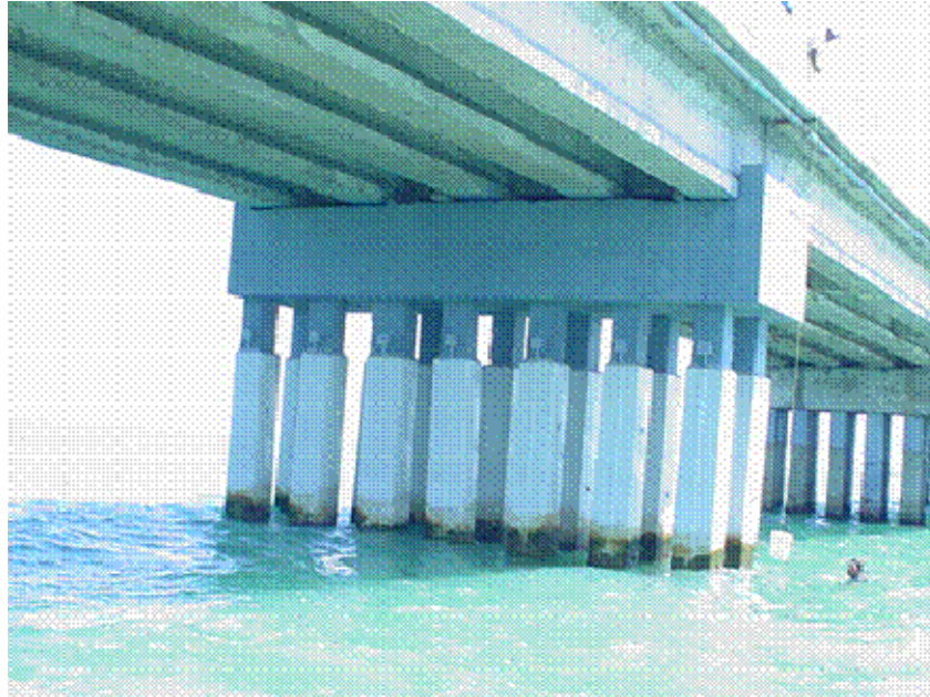
Figura 5. Mismo sistema de protección catódica con encapsulamiento usado en uno de los caballetes del puente en Campeche.
