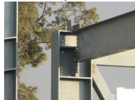
Trazos de fabricación mal realizados debido a lo cual las conexiones no coinciden
