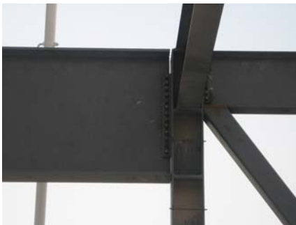
Conexiones sin respetar distancias mínimas a borde en tornillos
