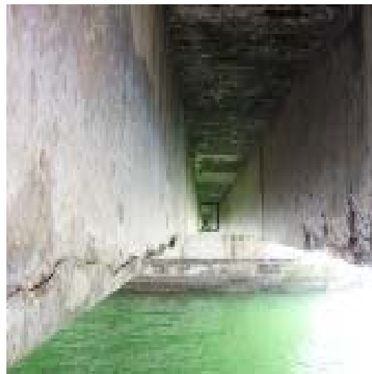
Figura 2. Manifestación del primer síntoma de corrosión de la barra de acero en las vigas y desprendimiento del recubrimiento inferior por corrosión de la barra.
