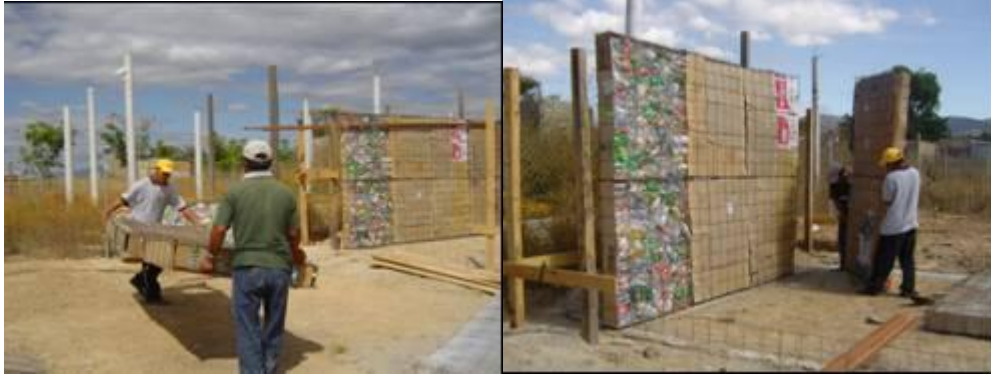
Figura 2. Maniobra y montaje de paneles para la construcción de muros
