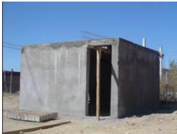
Figura 3. Modelo experimental construido con paneles tipo sándwich
