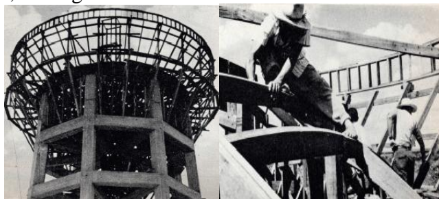
Figura 1. Construcción de tanques tipo Intze en la década de los 60's en Yucatán 4
