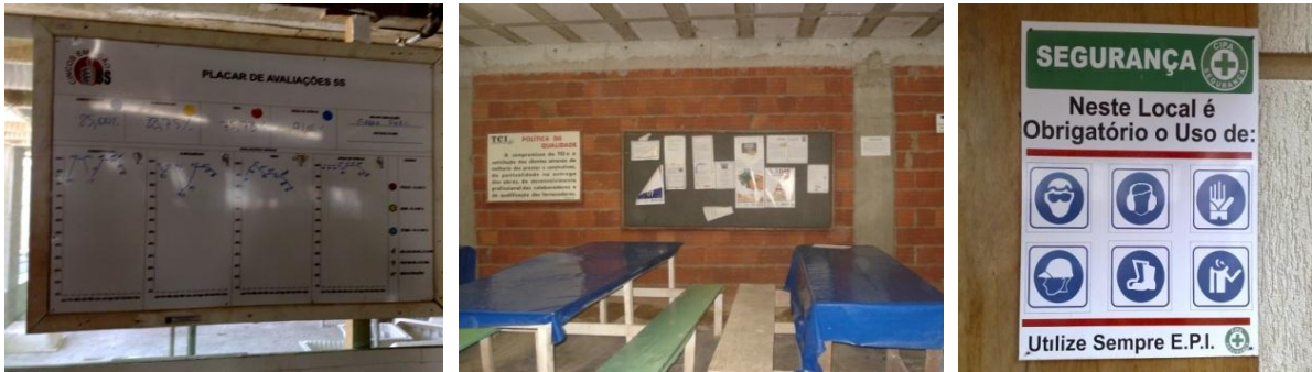
Figura 3 – Avaliação do programa 5 “S”, organização e limpeza do refeitório e a sinalização na obra
