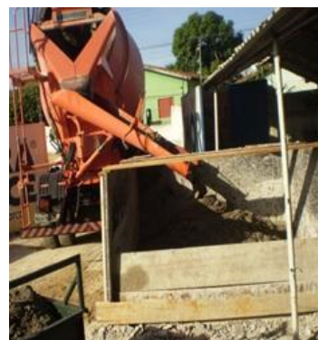
Figura 6 – Armazenamento da argamassa
