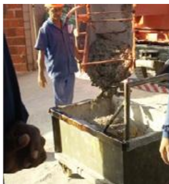
Figura 5 – Descarregamento e transporte da argamassa
