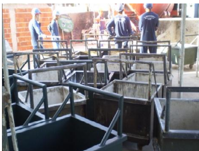
Figura 4 – Chegada da argamassa no canteiro
