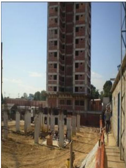
Figura 2 – Canteiro de obra do estudo de caso
