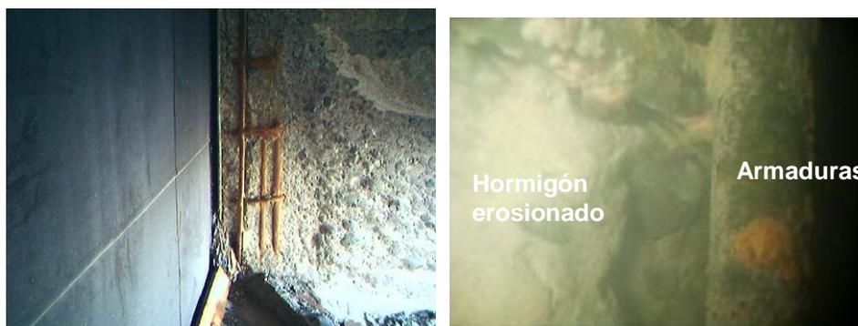
Figura 1. Daños típicos de erosión de la obra de referencia.
