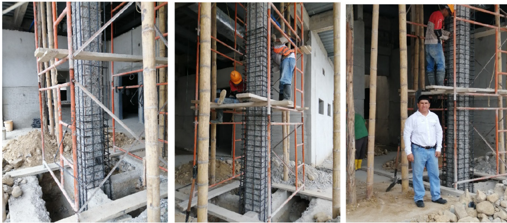
Figura 25. Colocación del Acero de Refuerzo.
