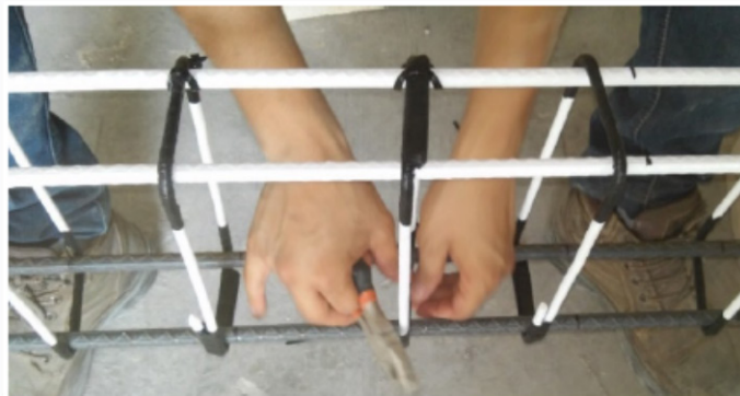
Figura 2. Aislamiento de AR longitudinal del transversal.
