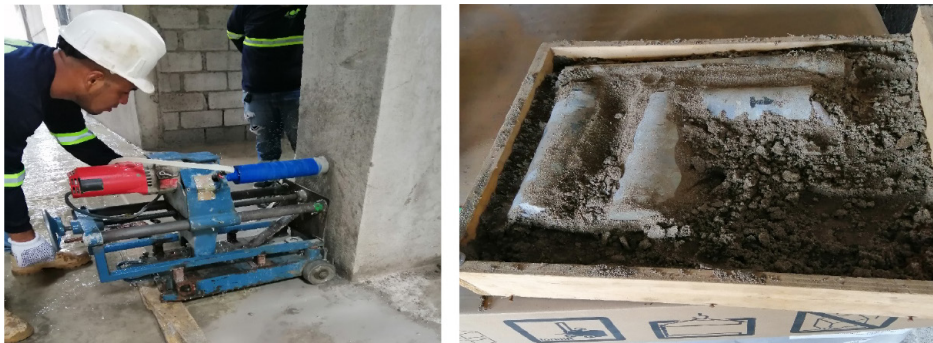
Figura 8. Extracción de núcleos en vigas y columnas bajo la norma ASTM C 39/C 42M, obtención y ensayo de núcleos (testigos) taladrados (extracción, preparación y ensayo).
