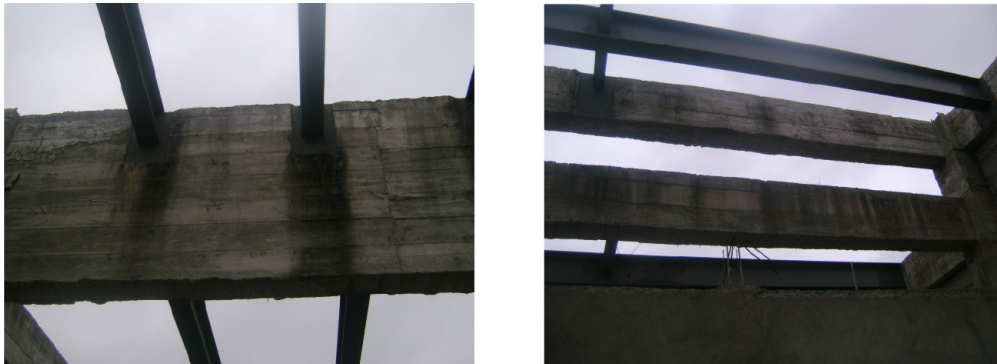
Figura 6. Manchas en el hormigón en vigas y juntas frías, elementos de gran sección (viga fuerte y columna debil).
