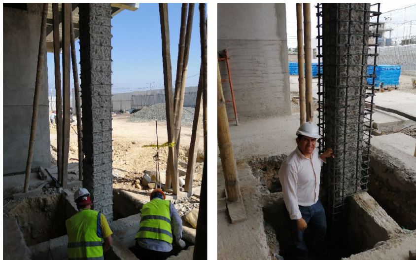
Figura 26. Ampliación del área de cimentación.
