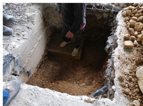
Figura 2. Realización de calicatas tanto en el Interior y Exterior de la Estructura.
