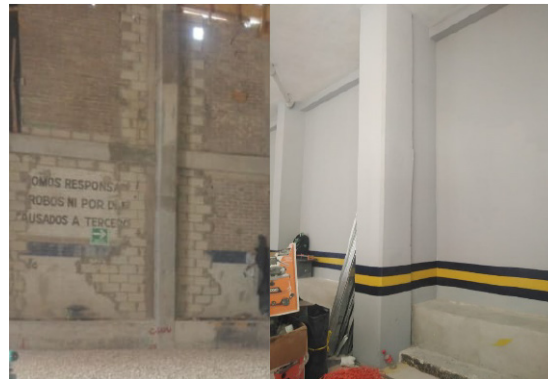
Figura 4. Fotos representativas de la reparación terminada.
