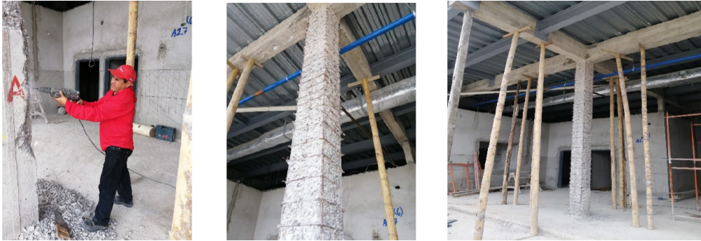
Figura 24. Proceso de Encamisado de columnas en varias columnas donde las cargas son más críticas.
