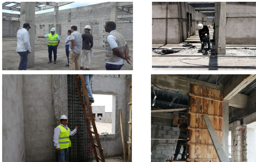
Figura 23. Reforzamiento con muros de corte en varios ejes de la estructura.
