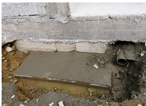
Figura 2. Realización de calicatas tanto en el Interior y Exterior de la Estructura.
