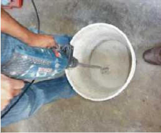
Ilustración 2 Método de mezclado mediante espas de acero.
