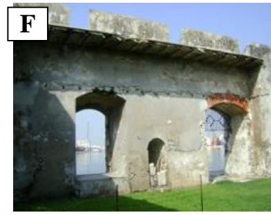
F: Cortina Sur, M 8 Muro de las argollas
