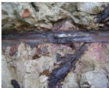
Ensayo in-situ Puente Jesús Carranza
