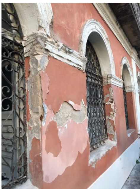
Figura 2. Janelas do corredor do museu.
