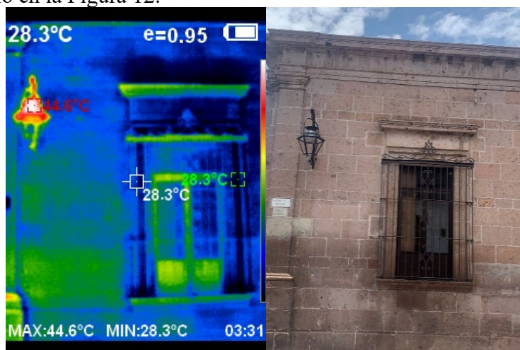
Figura 12. Resultados de obtención de toma de temperatura superficial en fachada de edificio en calle Allende, con orientación al sur.
