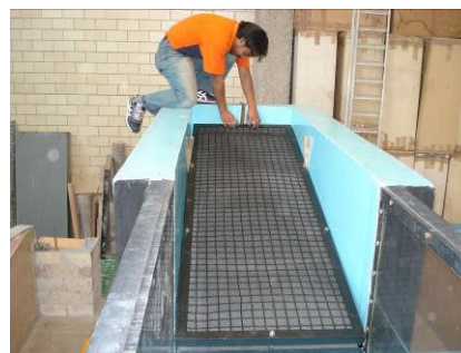
Figura 9. Terminación del mantenimiento del amortiguador y colocación del mismo.
